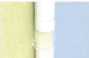
Boru manşonu alttan gelen iniş borusuna yapıştırın. Üstten gelen iniş borusunu boru manşonuna yapıştırmadan serbestçe yerleştirin. Bu noktada boruların rahatça genişlemesi için bir miktar boşluk bırakın. Her boru manşonunun altına muhakkak bir kelepçe tespit edilmelidir.
