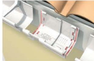
Dilatasyonlu ek parçasının her iki yanındaki dişli ve düz kısımlara kesintisiz şekilde ikişer şerit yapıştırıcı sürün. Oluğu sonuna kadar iterek yapıştırın.
