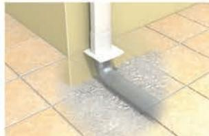
İniş borusunu dairesel bir alt yapı borusuna bağlamak için üniversal adaptör kullanın. Alt yapı bağlantısı için Nicoll rögar kullandığınızda; rögar kapağında bulunan dairesel deliğe üniversal adaptörle geçiş yapabilirsiniz.
