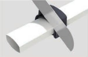
İniş borusunu bir kılavuz yardımıyla düzgünce kesin. Kesim çapaklarını zımpara ile temizleyin.
