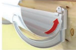
Eğer klasik kelepçe kullanıyorsanız; ilk önce oluğu kelepçelerin arka kısmına yerleştirin sonra oluğun ön kısmını aşağı doğru bastırarak kelepçelere klipsleyin. Oluk kelepçelere takıldıktan sonra yatay olarak rahatça hareket edebilmelidir.
